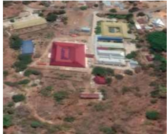
Gebouw met rode dak is de uitbreiding
