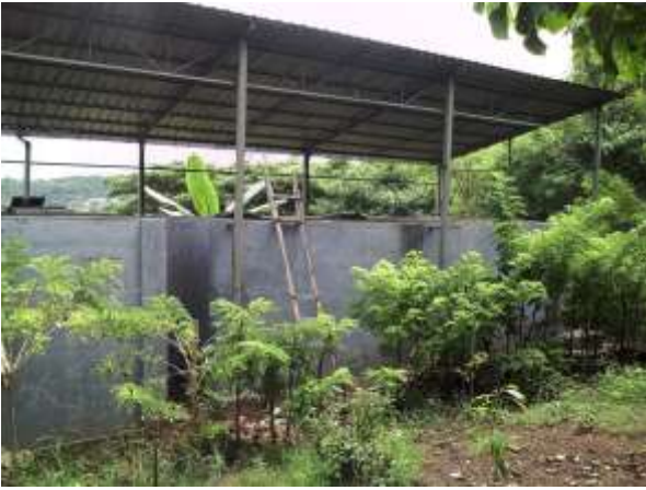
Watervoorraadbakken werden gerenoveerd
